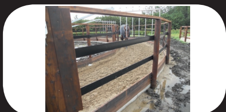
Type C 1x bovenregel 2x Kylix-band 2x plank hoefslag
