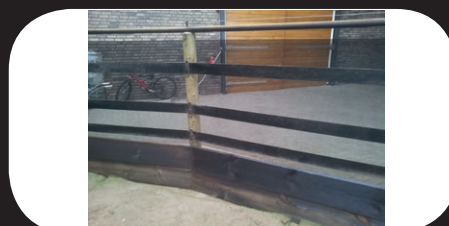
Type D 1x bovenregel 3x Kylix-band 2x plank hoefslag
